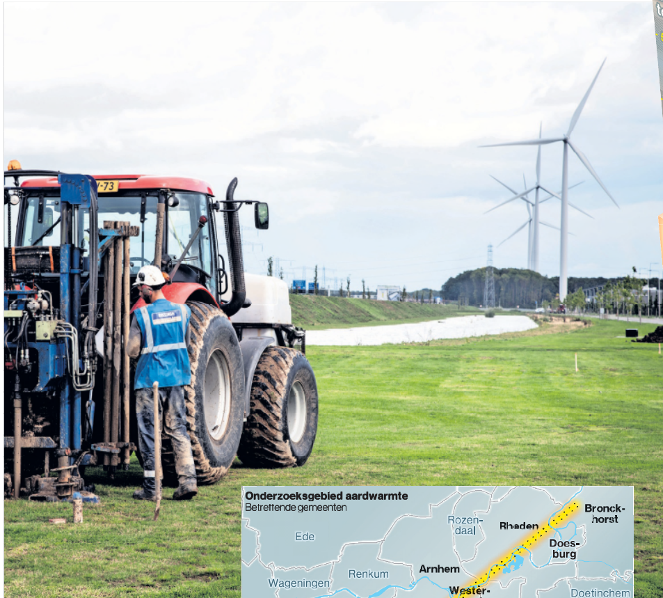
▲ Het boren van het gat langs de A15 bij Oosterhout waar de springlading in gaat.
